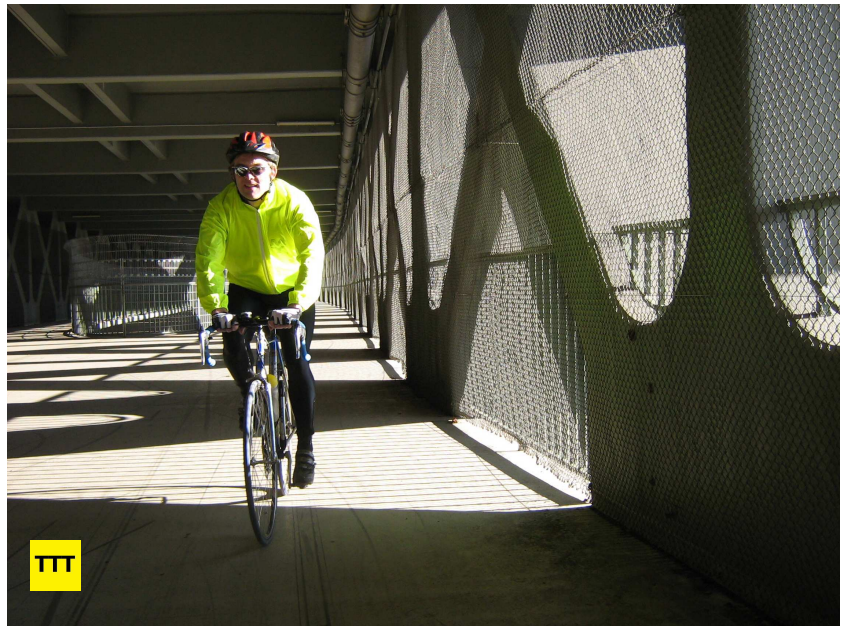
Ein Radler im Untergeschoß der Weyarner Autobahnbrücke. Zwei Meter weiter oben rauschen Lastwagen und Autos über den Asphalt.
